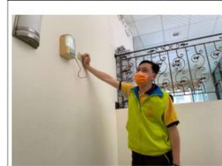
實地訪視校外賃居處所(檢視緊急照明)
