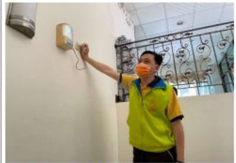
實地訪視校外賃居處所(檢視緊急照明)
