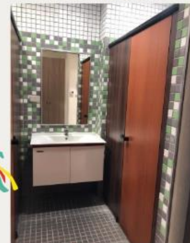
寢室衛浴設備
