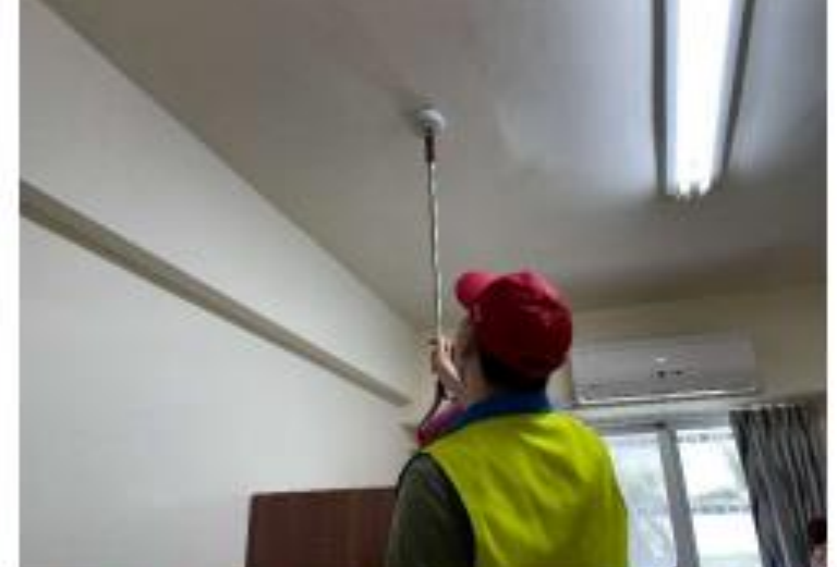
實地訪視校外賃居處所(檢查偵煙器)
